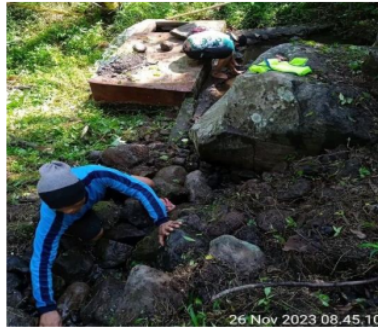
Gambar 1. Pembersihan saluran air Sumber: Kepala Dusun Mrunten Kulon
